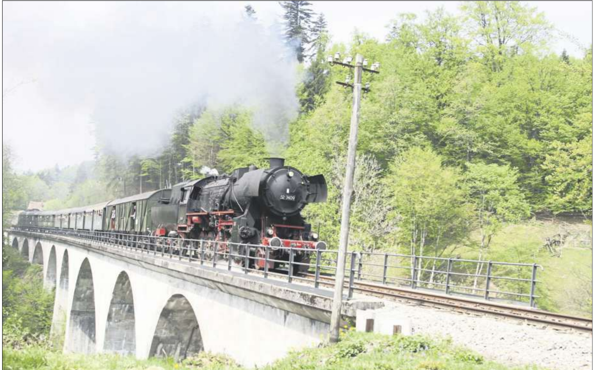
Nur noch dieses Jahr darf das Viadukt Laufmühle von der Schwäbischen Waldbahn befahren werden. Dann steht eine teure Grundsanierung an.
