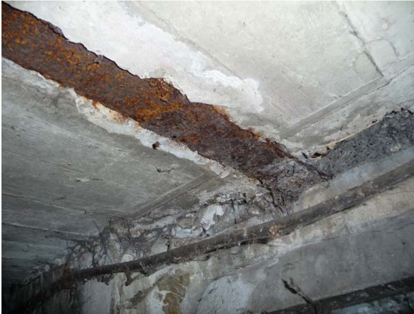
Kappendecke Keller Stahlträgerauflager stark verrostet
