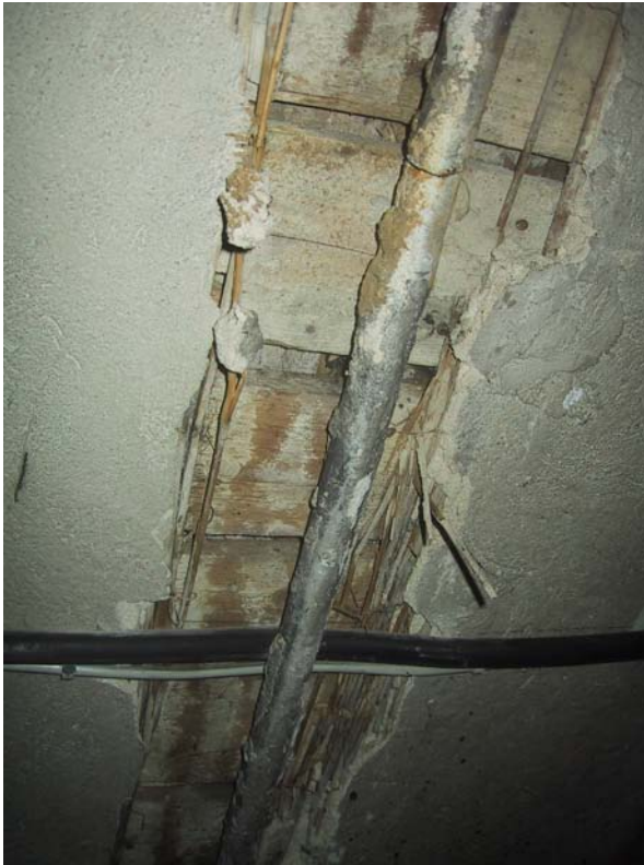
Kellerdecke Bereich Heizung als Holzbalkendecke
