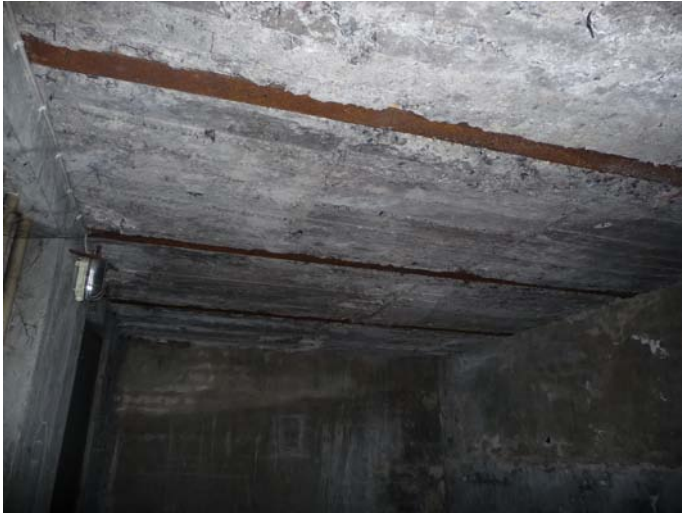
Kappendecke Keller Stahlträger stark verrostet
