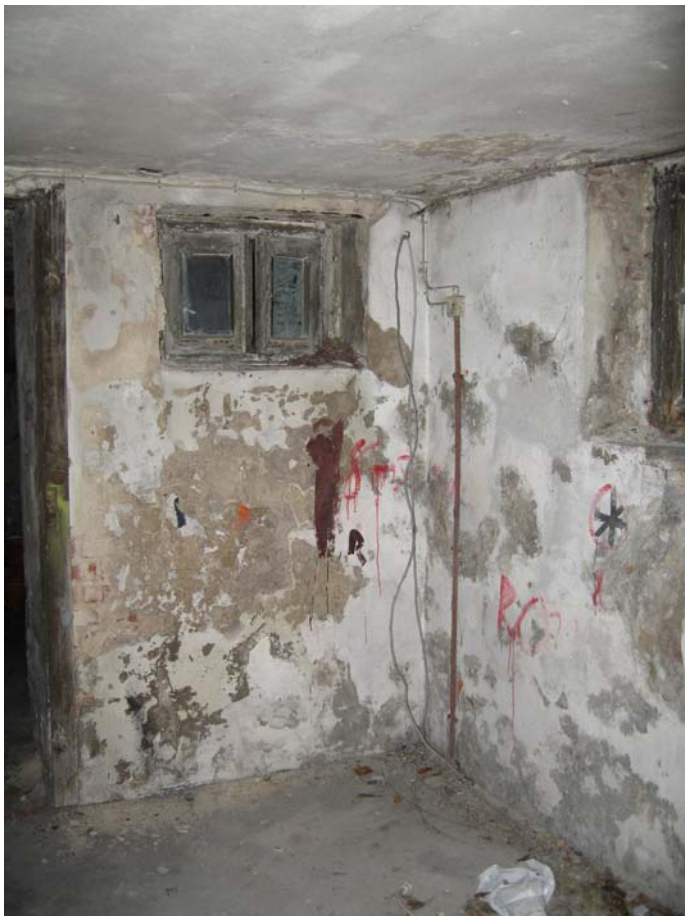
Kelleraussenwand durchfeuchtet
