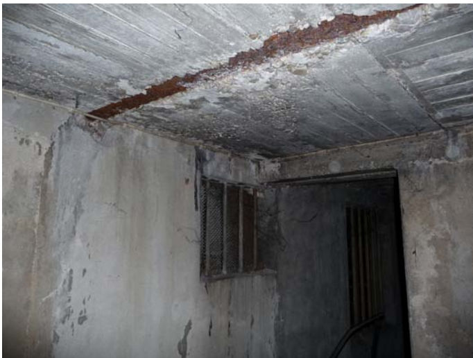
Kappendecke Keller Beton starke Abplatzungen
