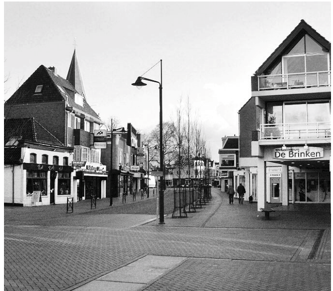
Shared Space in Haren, Niederlande: Keine Verkehrszeichen, nivelliertes Straßenland und lediglich orientierende „Begrenzungen“ für die Verkehrsteilnehmer
